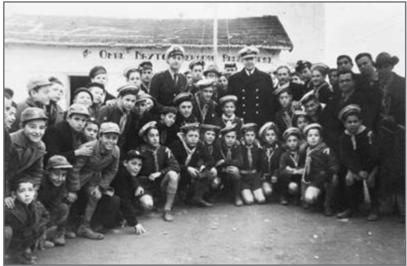
Η φωτό με τον Διάδοχο και μετέπειτα Βασιλιά Παύλο είναι μπροστά στη λέσχη Ναυτοπροσκόπων, στο κτήριο που ήταν κολλητό στον φάρο.
